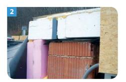
Oberfläche der EPS Dämmung ist die Rinnenaußenkante ersichtlich. Beachten sie bitte auch die Fugenbreite zwischen den Wärmedämmplattenstößen.
