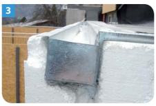
der Rinnenflansch mit nur einer Lage beschieferter Polymerbitumenbahn eingeklebt.
