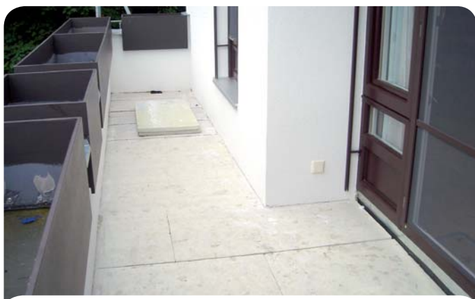
Hier wurde die Dämmung erhöht. Achten Sie auf die Anschluss- höhen bei der Terrassentür.
