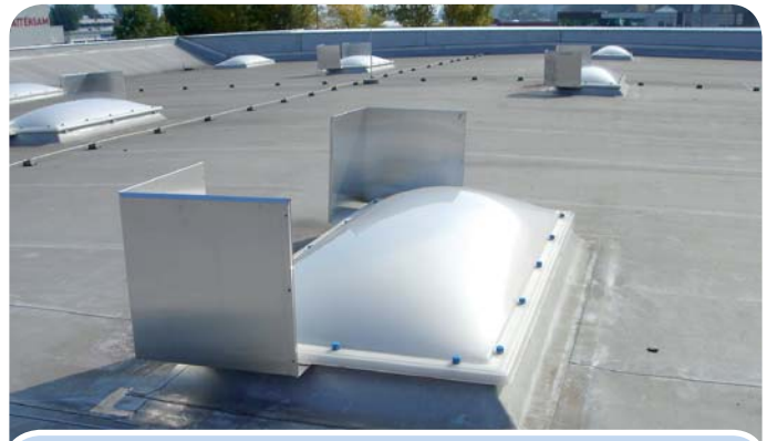
Flachdächer waren schon immer sehr begehrt. Hier ein modernes Industriedach.
