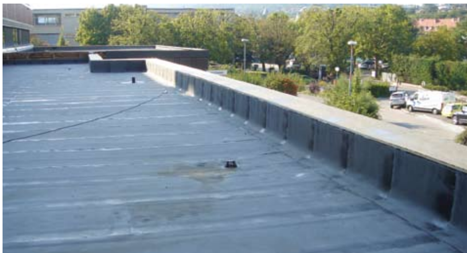
Klinikzubau in Niederösterreich: Die Dachabdichtungsfläche ist pultdachförmig in Richtung Niederschlagswasserableitung geneigt.
