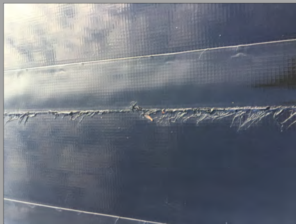
„17. IFB-SYMPOSIUM FLACHDACHBAU & BAUWERKSABDICHTUNG“ Dr. Udo Simonis
