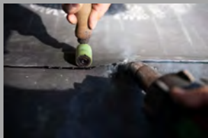
EPDM Bahn mit unterseitiger Bitumenmasse - Nahtfugung mittels Heißluft
