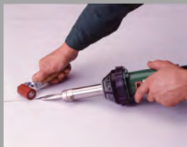
PVC-Dachbahn –Nahtfügung mittels Heißluft
