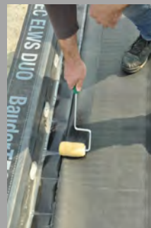
EPDM Bahn Nahtfugung mittels Klebebandtechnik „PreTape“
