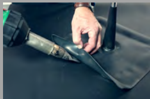
EPDM Bahn mit unterseitiger TPE-Schicht Nahtfugung mittels Heißluft „Thermofastfügetechnik“
