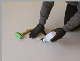
PVC-Dachbahn –Nahtfügung mittels Quellschweißung
