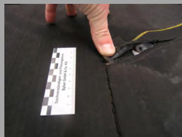
„17. IFB-SYMPOSIUM FLACHDACHBAU & BAUWERKSABDICHTUNG“ Dr. Udo Simonis
