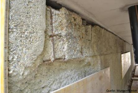
Freiliegende Armaturen eines statisch relevanten Bauteils
