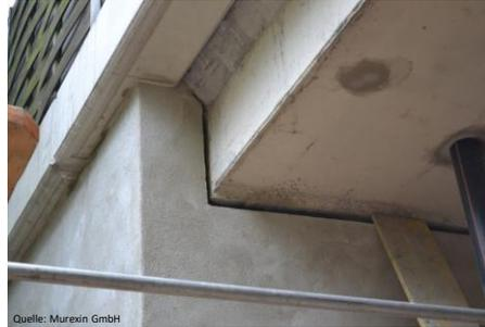
Fachmännisch gefertigte Betoninstandsetzung mit geeigneten Produkten (EN 1504)
