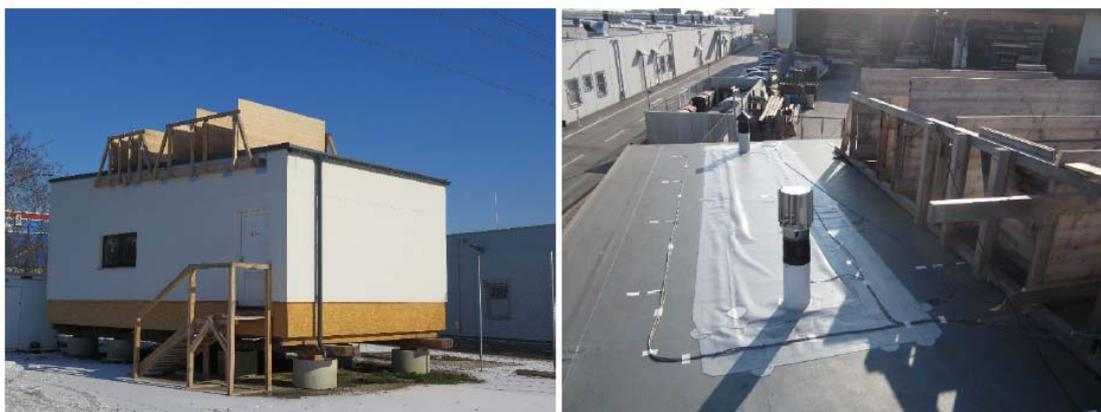
Abbildung 5: Forschungshaus der Holzforschung Austria am Standort Wr. Neudorf (links) und in die Dachfläche integriertes Dachelement mit Sanierungsaufbau (rechts, 4,78 m x 0,78 m).
