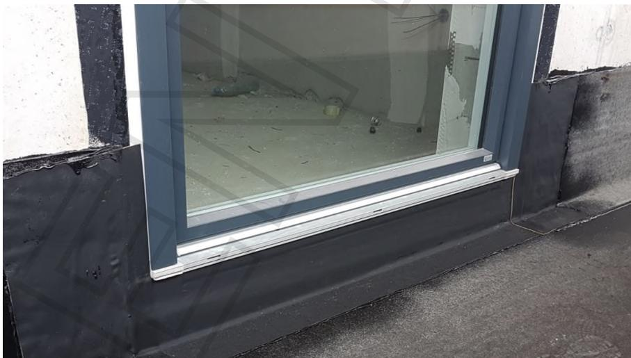
Abbildung 1 : Beispiel eines Anschlusses der Abdichtung an ein bodentiefe Fenster- u. Türelemente
