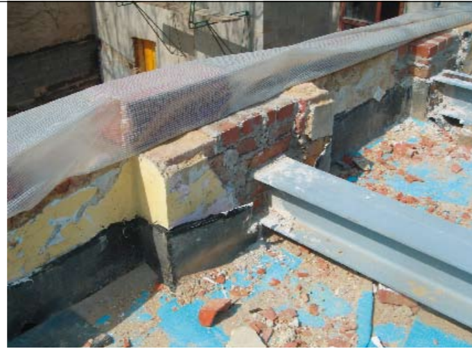
Falscher Dachrandabschluss.
