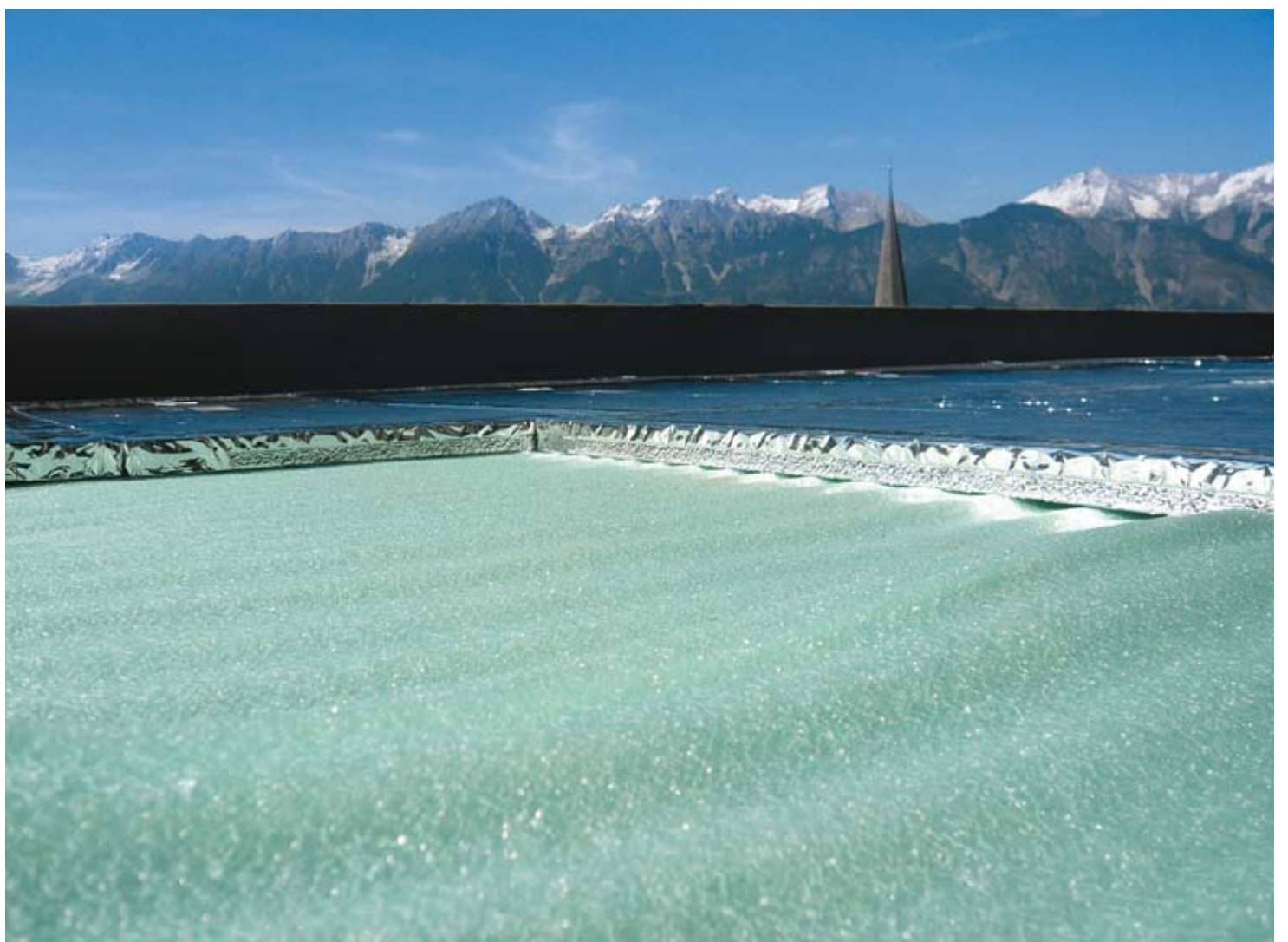
Vakuumdämmung auf Schutzlage. Fotos: Wolfgang Hubner
