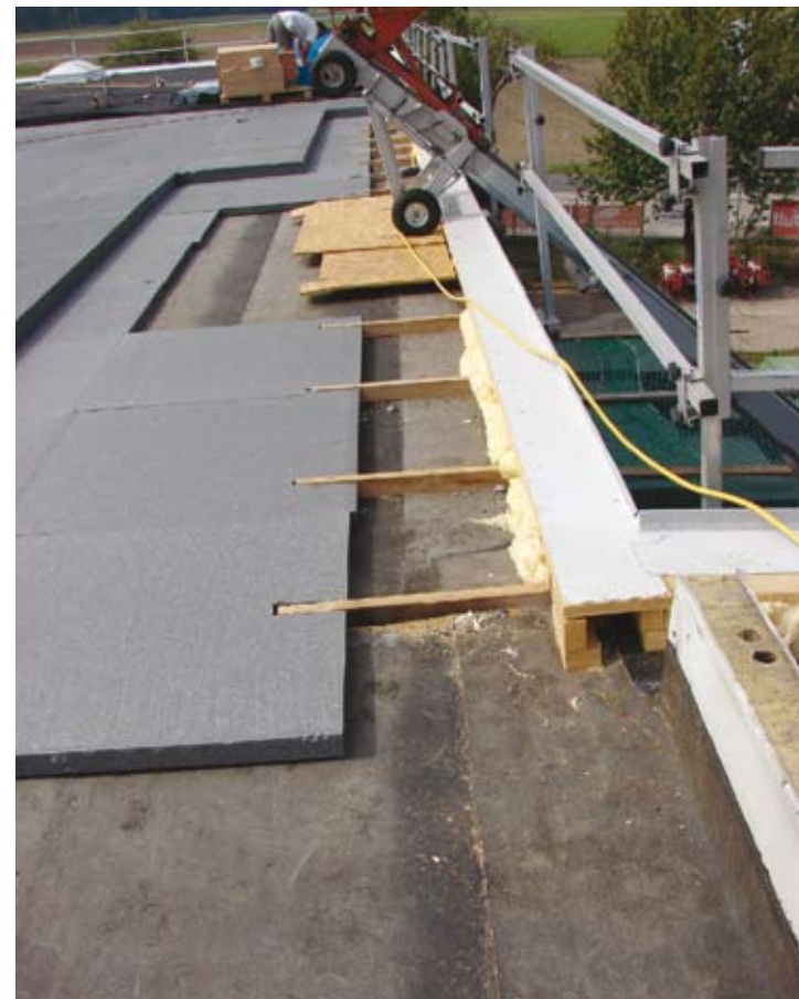
Dachrandabschluss. Fotos: Wolfgang Hubner
