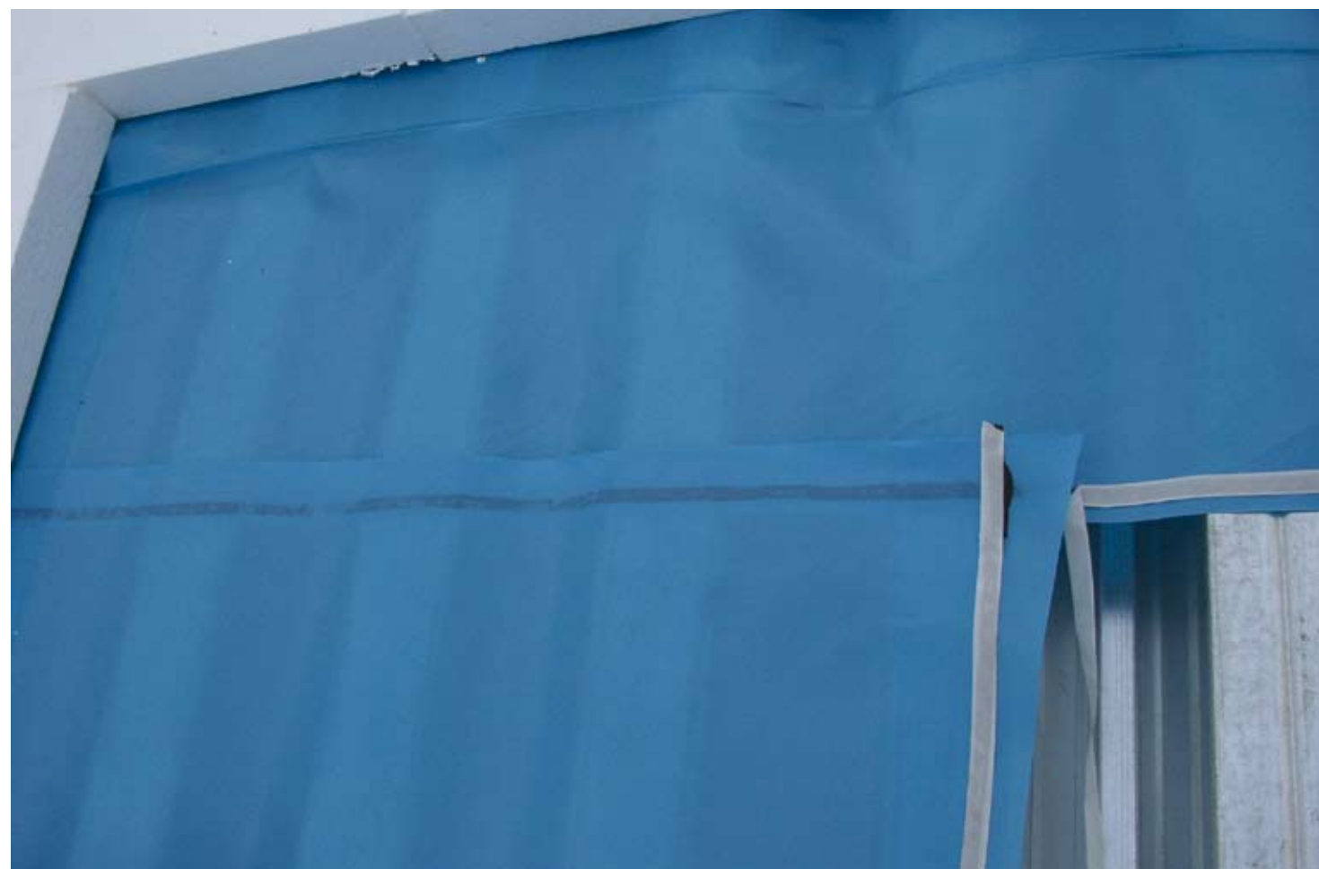
PAE Dampfsperrfolie verklebt
