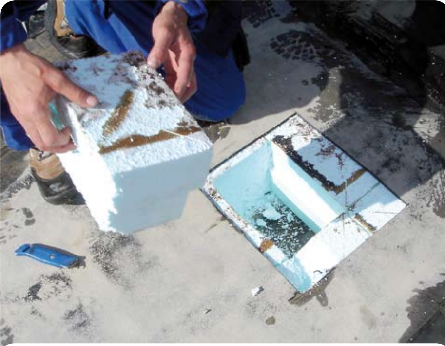
Hier sieht man die Öffnung eines Warmdaches.
