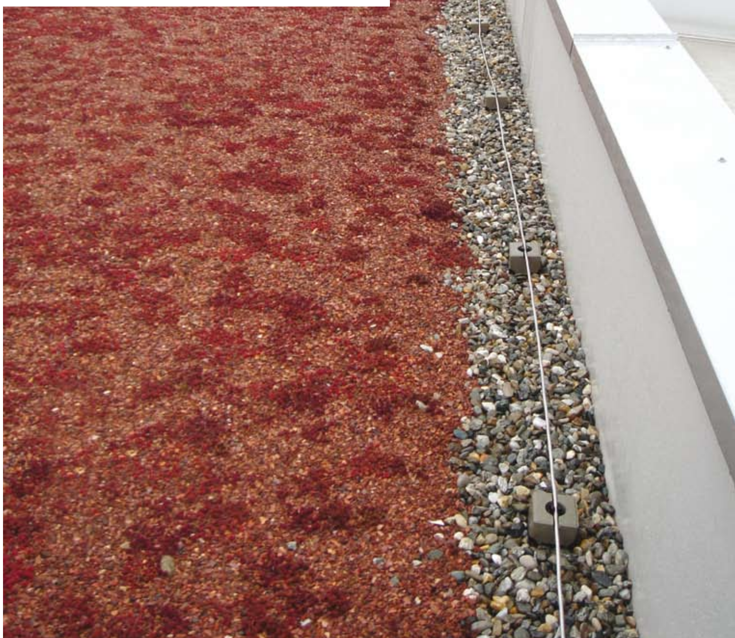
Kiesrandstreifen im Attikabereich. Foto: Wolfgang Hubner
