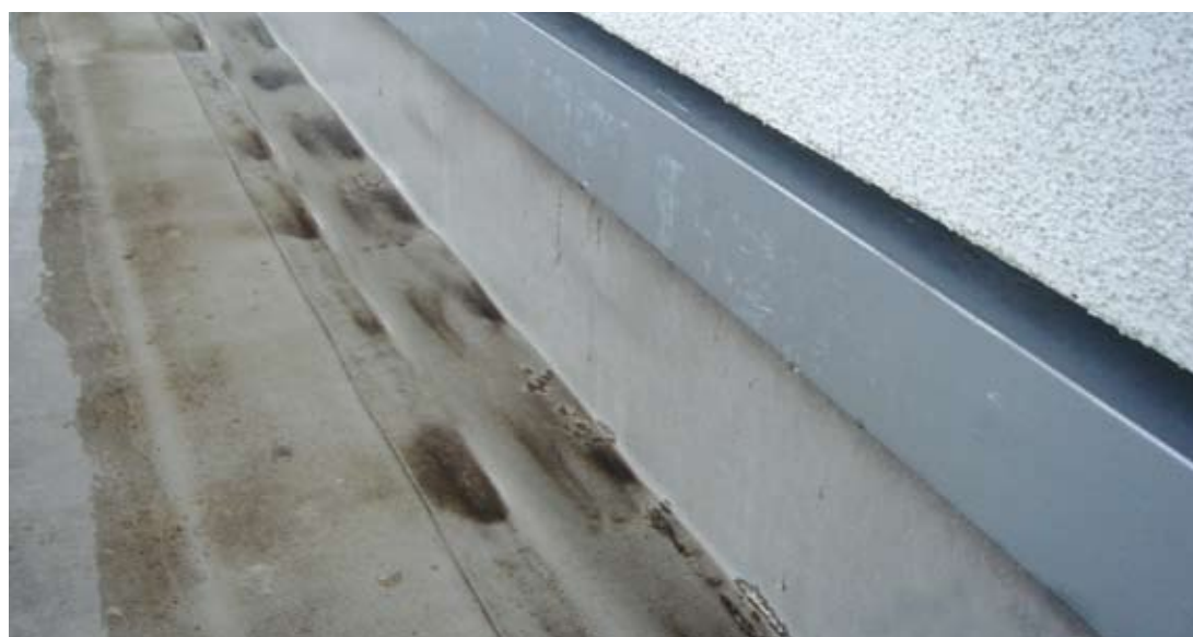
Anschluss WDVS-Fassade. Fotos: Wolfgang Hubner
