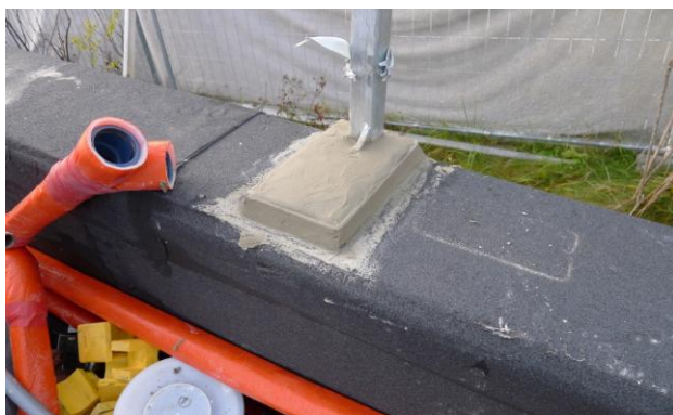
Anschluss an Dacheinbauten
