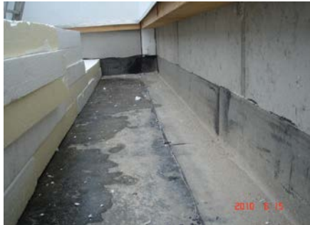
Terrassen-Fassadenanschluss
