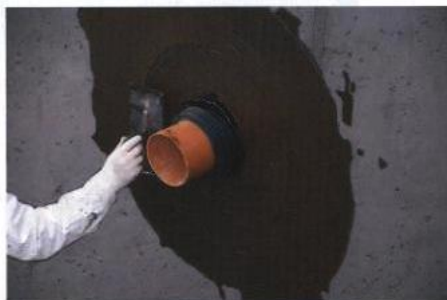
TROCKENLEGEN. Befestigen der Rohrabdichtung am Untergrund
