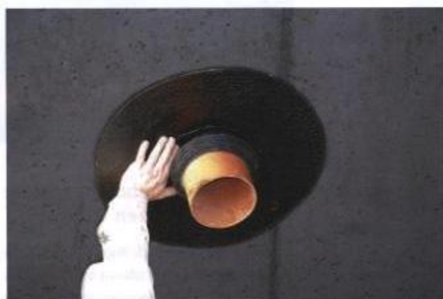
TROCKENLEGEN. Befestigen der Rohrabdichtung am Untergrund
