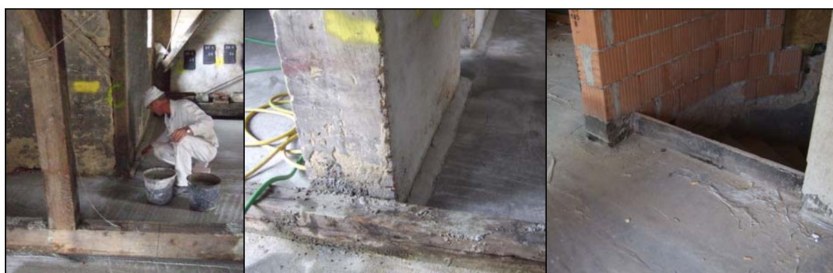
Abb. 3: links: Herstellung einer dreiecksförmige Hohlkehle Mitte: dreiecksförmige Hohlkehle bei Kaminmauerwerk rechts: Anschluss Bauschutzabdichtung an Holzbrett bei Stiegenaufgang
