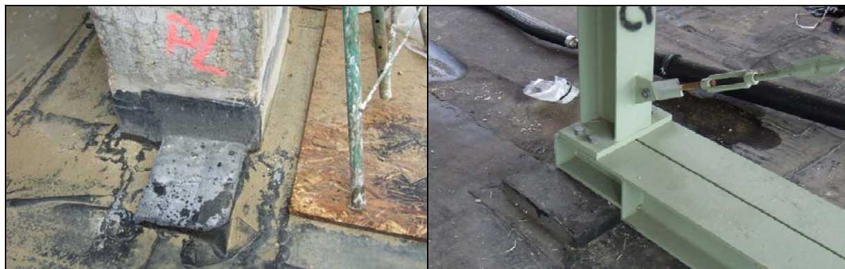
Abb. 5: Sockeln für Stahlstützen
