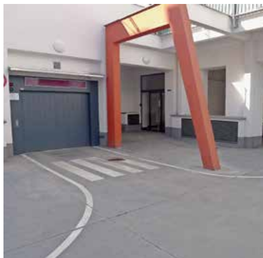
↑↑ Lüftung, Wandanschluss ↑ Garagentoranschluss ohne Rigol
