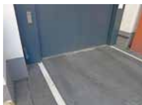
↑↑ Lüftung, Wandanschluss ↑ Garagentoranschluss ohne Rigol
